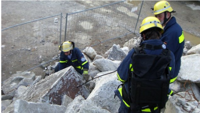
Absuchen eines Hohlraumes im Trümmergelände
